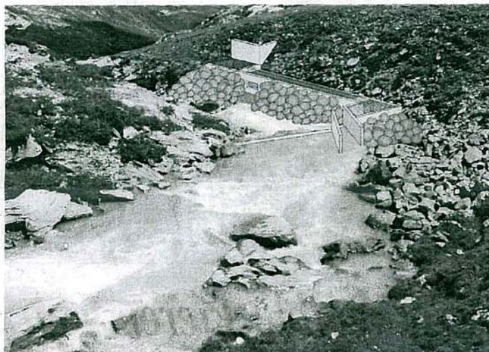
... und sollen in Zukunft am Ausgang der Ebene gemäss dieser Visualisierung von Flims Electric für die Stromproduktion gefasst werden.
