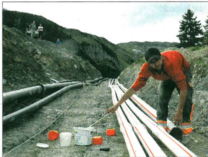
Multifunktional: Über den zugedeckten Druckrohren werden die Leitungen für die Beschneigung und Stromversorgung eingelegt.
