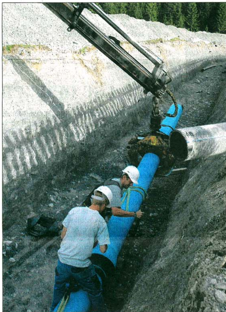
Grossbaustelle: Im Rahmen des Wasserwelten-Projekts werden 20 Kilometer Druckleitungen verlegt.
