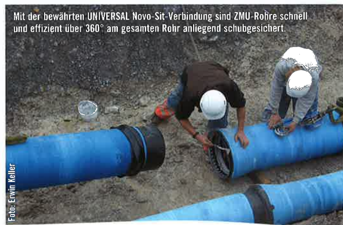
Zum Einsatz kamen ZMU-Vollschutzrohre in den Nennweiten DN900, DN400 und DN500.
